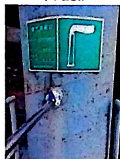
◎33DA034 3#角材锤破排 气口
